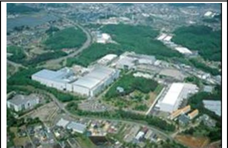
白河工場全景
