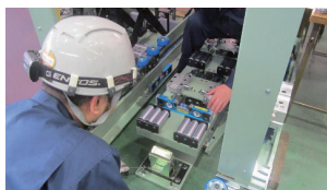
現場作業風景
