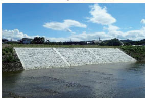
河川工事竣工写真
