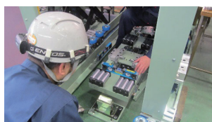
現場作業風景
