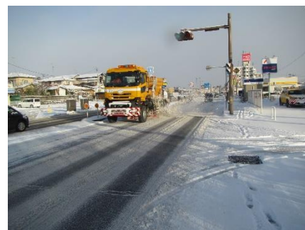
郡山 4 号維持補修工事
