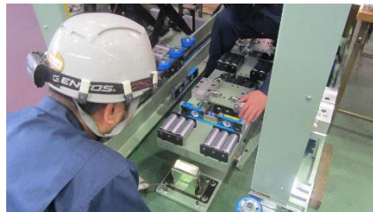
現場作業風景
